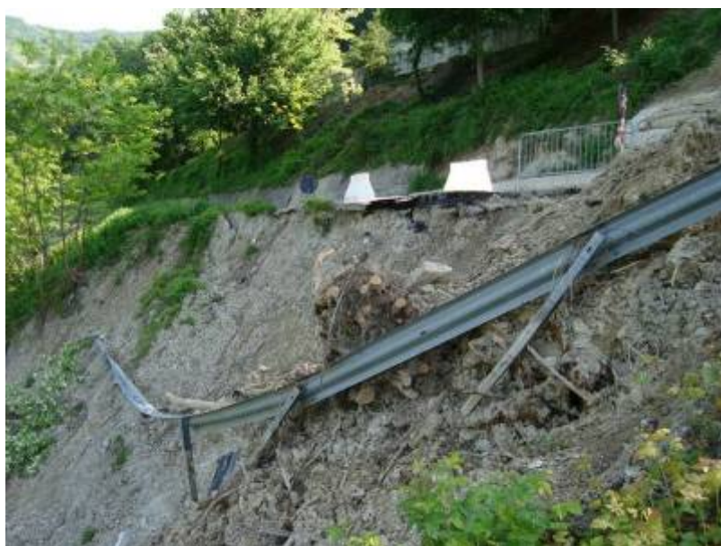
Ciglio superiore della frana con coinvolgimento della SP 281
