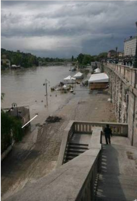
Foto di sinistra, Po ai Murazzi. La piena ha occupato l'intera sezione, invadendo i locali e lasciando al suo ritirarsi abbondanti depositi in primo piano; la riga bianca indica il livello idrometrico della piena, dedotto dall'altezza del materiale flottante. Foto a destra: particolare della foto di sinistra.
