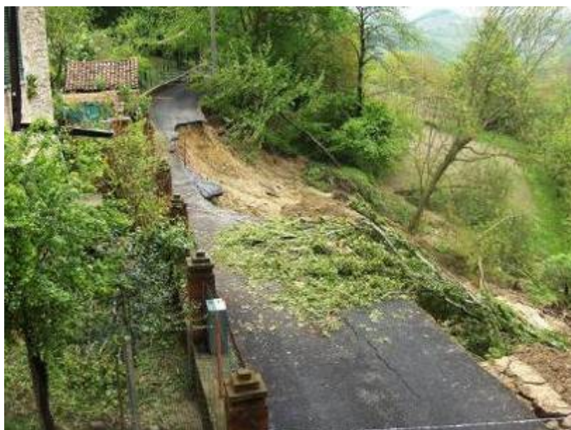
Fenomeno franoso in comune di Cassinasco
