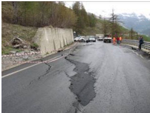
Comune di Pragelato: a sinistra, fessurazioni e ribassamento del manto stradale della S.R. n°24 per Sestriere; a destra, lo scivolamento ha messo a nudo il cordolo esterno della strada e la parte superiore dei micropali.
