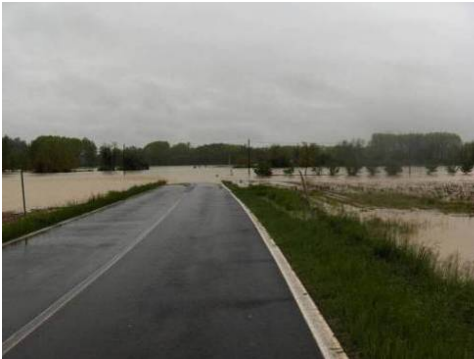
Torrente Bobore – Esondazione alla confluenza con il Triversa e con il Canale del Molino
