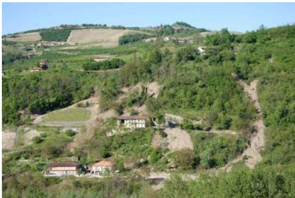
Veduta panoramica dei dissesti in località Mensa
