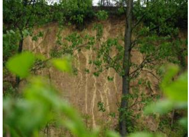
Evidenze frontali di percolazione della porzione fluida ancora attive lungo scarpata
