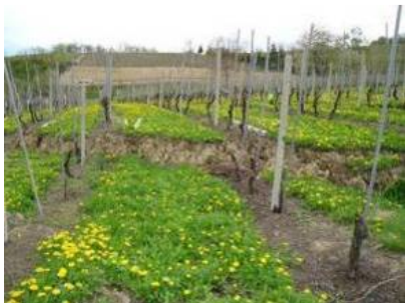
Franamento di un vigneto nel settore sommitale della frana
