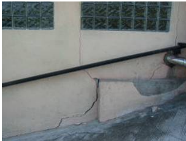
Comune di Antignano: a sinistra, abitazione privata coinvolta e fratture del manto stradale; a destra, fratture di trazione sviluppate sui muri perimetrali dell'abitazione interessata (a destra).
