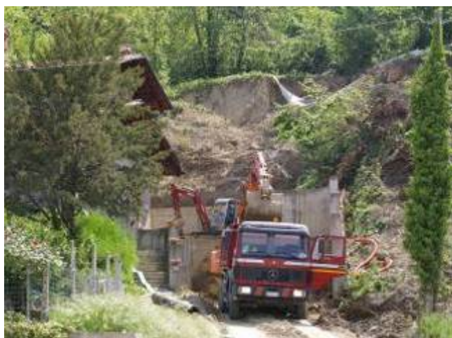
Fotografia scattata il 12 maggio 2009 dalla strada provinciale verso il coronamento della frana. I lavori di rimozione del materiale franato sono ancora in atto
