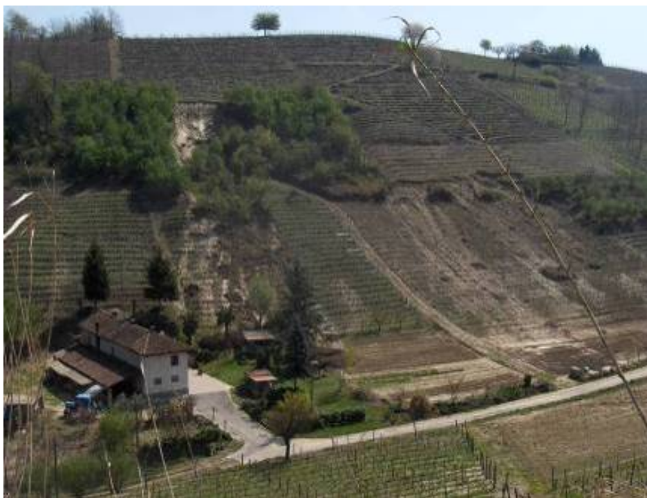
Comune di Mombercelli - Frana rotazionale
