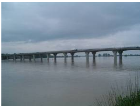
Viadotto della A26, con zona inondata a monte di Alessandria
