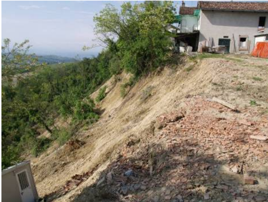
Particolare del cortile e delle pertinenze coinvolti dal franamento.
