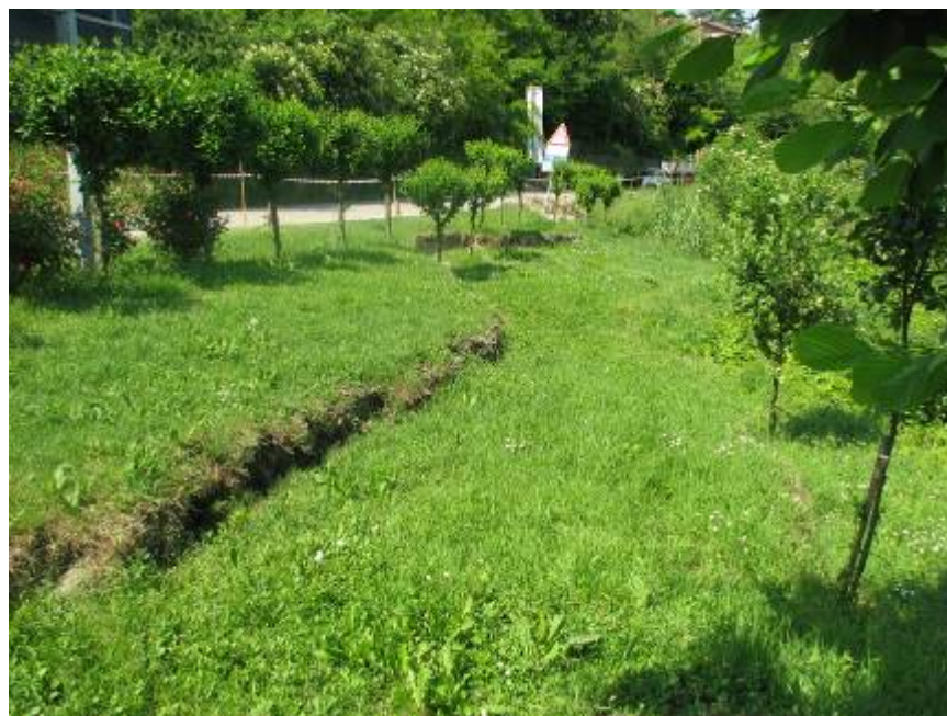
Comune di Antignano: parte del coronamento della frana.
