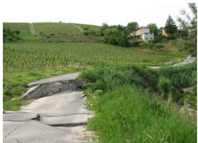
Comune di Canelli: a sinistra, coronamento dello scivolamento traslativo, a destra, danni al strada comunale.
