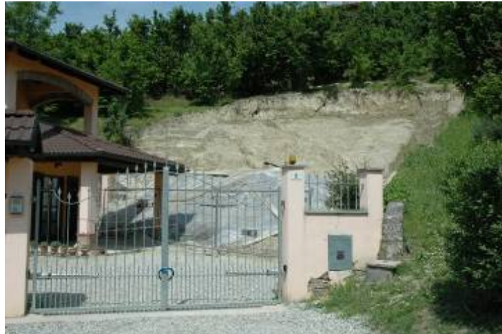
Castagnole delle Lanze: porzione di edificio minacciata da un movimento gravitativo del versante soprastante
