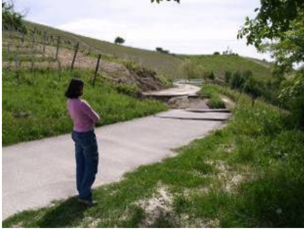
Treiso, strada per C. Basso. Riattivazione di uno scivolamento planare originatosi a dicembre 2008
