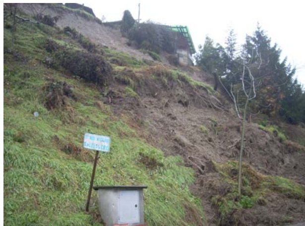
Colamento in località Tetti Trivero, Baldissero Torinese, situazione dopo le piogge del 14-17 dicembre 2008 (foto dott. Genovese)
