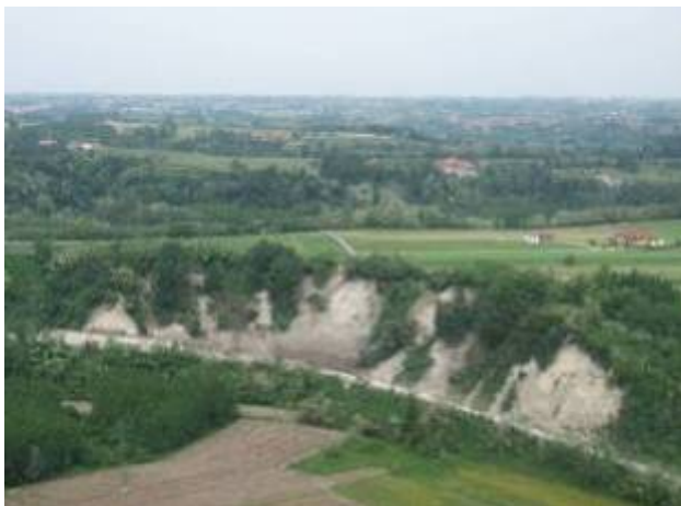
Bastia Mondovì, SP 12. Diffusi colamenti superficiali hanno causato l'interruzione della viabilità. I lavori di sgombero e di sistemazione delle scarpate hanno comportato la chiusura della strada per circa 15 giorni
