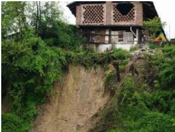
Strutture antropiche prospicienti la porzione di distacco posti sull'orlo di scarpata
