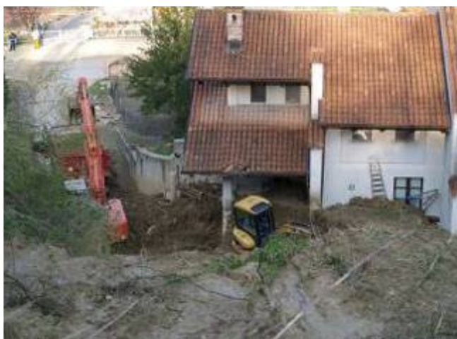
Fotografia scattata il 6 aprile 2009 dal coronamento dello scivolamento rotazionale. In primo piano l'abitazione investita dal materiale franato, in secondo piano la strada provinciale
