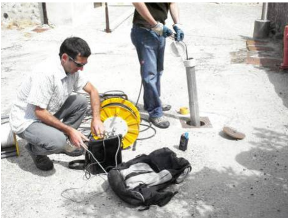
Letture inclinometriche in corso presso la località Concentrico del Comune di Feisoglio (CN)
