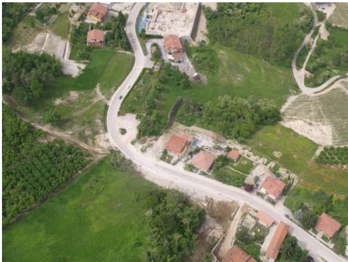
Ripresa da elicottero del versante in frana per scivolamento planare. In primo piano, sulla destra dell'immagine, parte degli effetti prodotti dalla frana per scivolamento rotazionale innescatasi a monte della SP5
