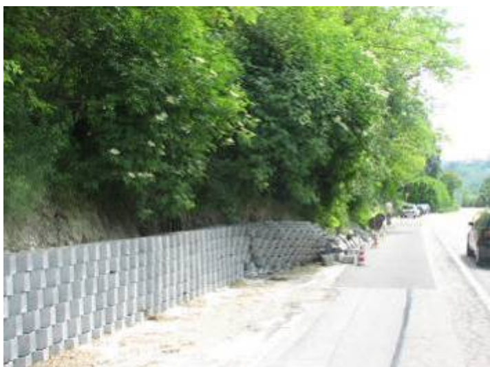
Comune di Aramengo: a sinistra, muretto in blocchi di cemento armato parzialmente distrutti lungo la Strada Regionale 458 per Casalborgone; a destra, colamento di terra e materiale vegetale in prossimità della Chiesa Comunale.
