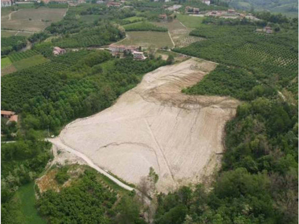
Montelupo Albese, loc. Barili. Scivolamento planare originatosi nella primavera 2002 e riattivatosi in fasi successive. Ad aprile 2009 si è verificata una riattivazione al piede del dissesto, evidente nell'immagine, che ha causato la traslazione della strada
