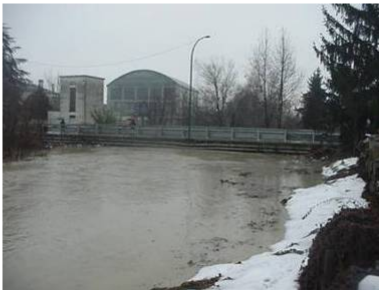
Torrente Versa - Ponte di Corso Alessandria
