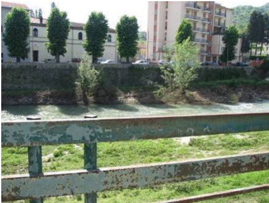
Località Mulino di Torre Bormida, il torrente inonda l'area limitrofa al canale senza provocare danni.
