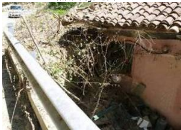
Somano, Mulino di Somano. Colamento veloce innescatosi sulla ripida scarpata soprastante la strada; il materiale franato ha ostruito la strada e si è arrestato contro lo spigolo di un'abitazione ubicata a fianco della strada
