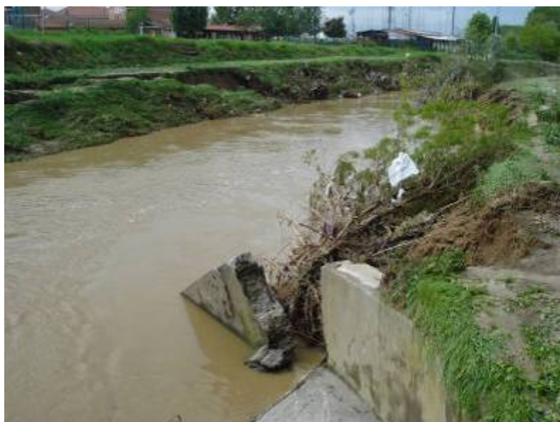
T. Banna a valle del ponte di Via Cavour. Erosione dei rilevati di servizio in terra su entrambe le sponde e danni ad opera di scarico
