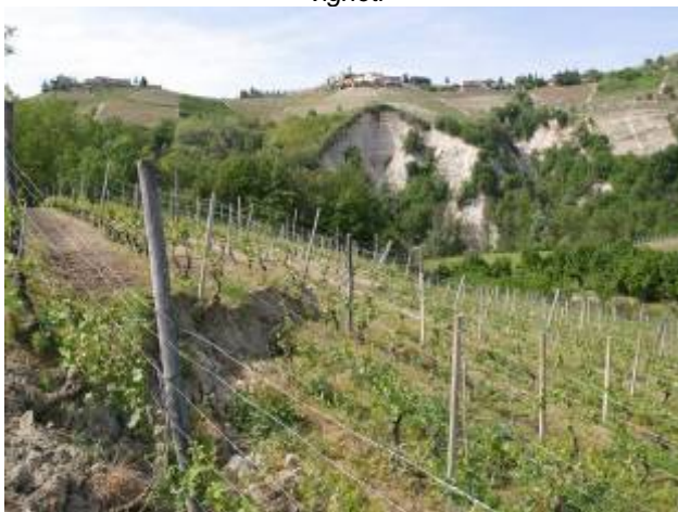
Carno, C. Nosetti. Ampio scivolamento planare, che ha causato danni ai vigneti, al nocciolo, alla strada e alle pertinenze della cascina
