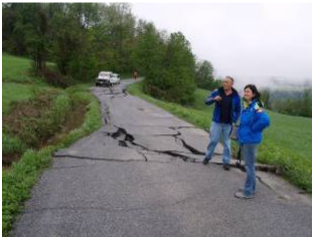
Mondovì, Villa Montezemolo. Scivolamento planare originatosi durante l'evento di aprile 2009
