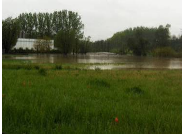
Tigliole, torrente Triversa, settore inondato in corrispondenza di un complesso industriale. (foto Di Martino del 27/04/09)
