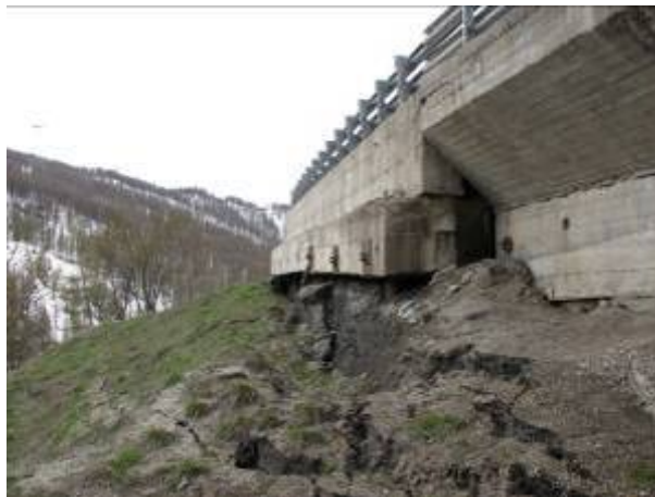
Comune di Pragelato: a sinistra, fessurazioni e ribassamento del manto stradale della S.R. n°24 per Sestriere; a destra, lo scivolamento ha messo a nudo il cordolo esterno della strada e la parte superiore dei micropali.
