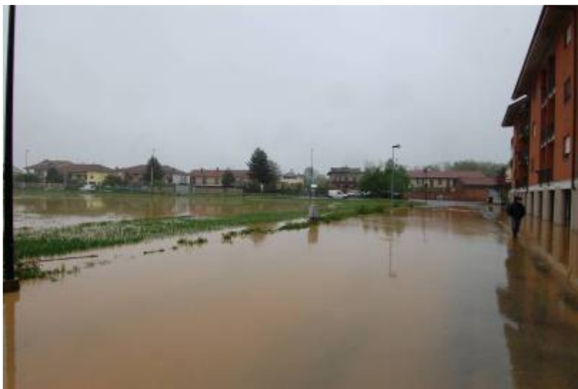
Edifici allagati a valle (nord) della S.S. 122 per Carignano
