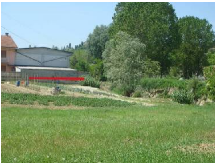
Pertinenze di una cascina in sponda destra del T. Tinella lambite dalla piena. La linea indica l'altezza delle acque. L'edificio è a ridosso del corso d'acqua che scorre alla sua destra (deflusso verso l'osservatore)
