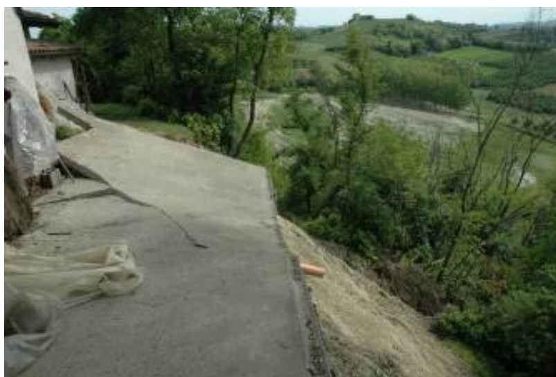
Castagnole delle Lanze: un'abitazione minacciata da fenomeni di arretramento di una scarpata di frana
