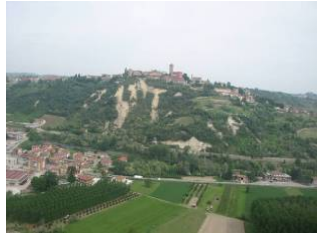
Santa Vittoria d'Alba. Colamenti veloci per fluidificazione della colture superficiale. Il materiale franato ha causato l'interruzione della linea ferroviaria Cavallermaggiore - Alba
